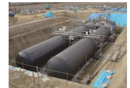
公園地下への大容量貯水槽の設置(災害時でも一定時間の応急給水が可能)
