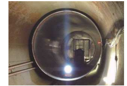
送水幹線の再整備(銅管の挿入)
