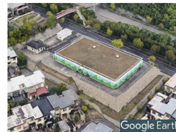
須磨特1高層配水場貯水槽
