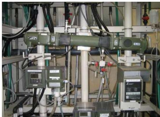
図5.2 ろ過水濁度の常時監視装置
