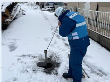
【音調棒による漏水調査の様子】
