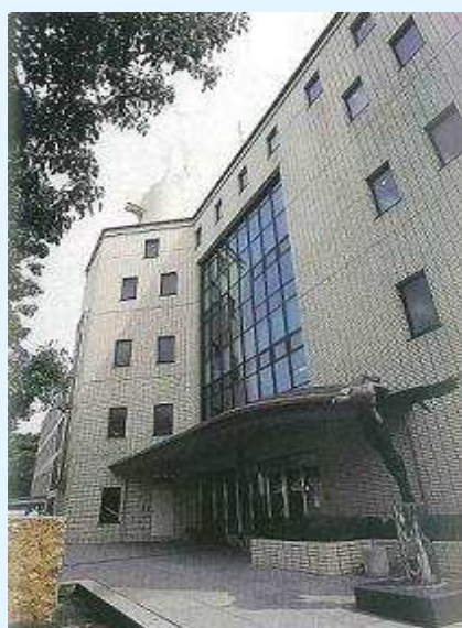
中部センター(1～2階) たちばな研修センター(3～5階)
