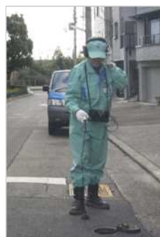
漏水調査の様子
