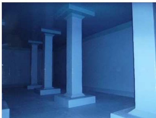
配水池の内面
