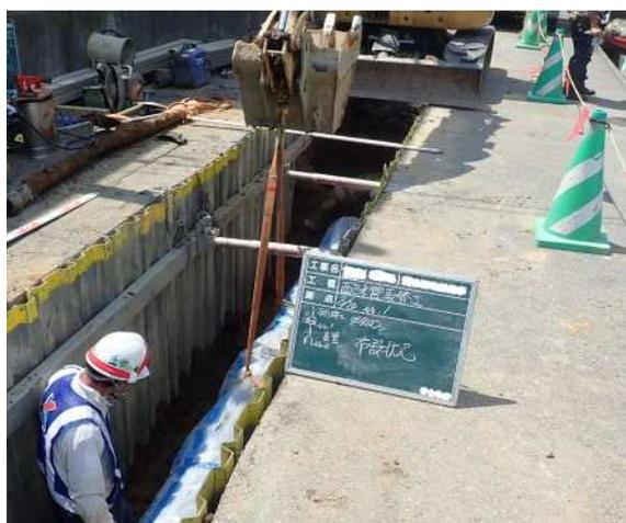
高度経済成長期に布設した大量の配水管が更新時期を迎えることから、経年劣化した配水管の更新・耐震化を引き続き推進します(40km相当)。
