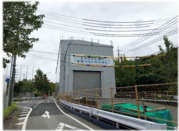
【シールドマシン発進基地】
