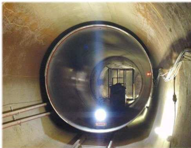
【更生工事の事例 (鋼管挿入)】
