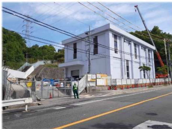
【花山ポンプ場 (工事中)】
