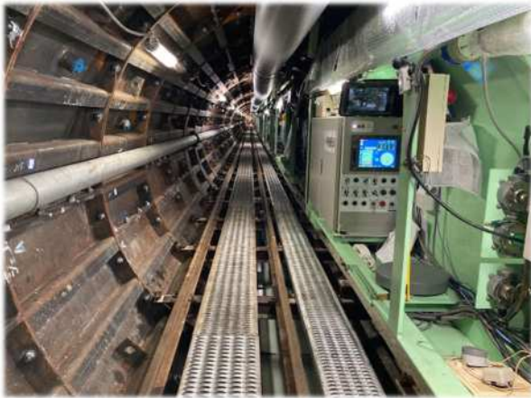
【シールドトンネル】
