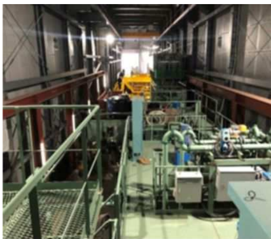
【シールド発進基地(防音ハウス内)】
