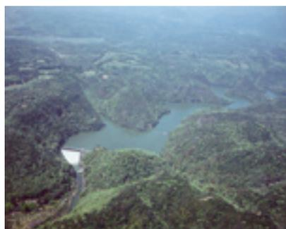
千苺貯水池は、市街地（上ヶ原浄水場）、北神地域（千苺浄水場）の両方へ水を送ることができ、予め取水量を制限し、貯水することにより、淀川などでの濁水でも十分な水量を確保することができる機能をもつ大変貴重な最大の自己水源です。
