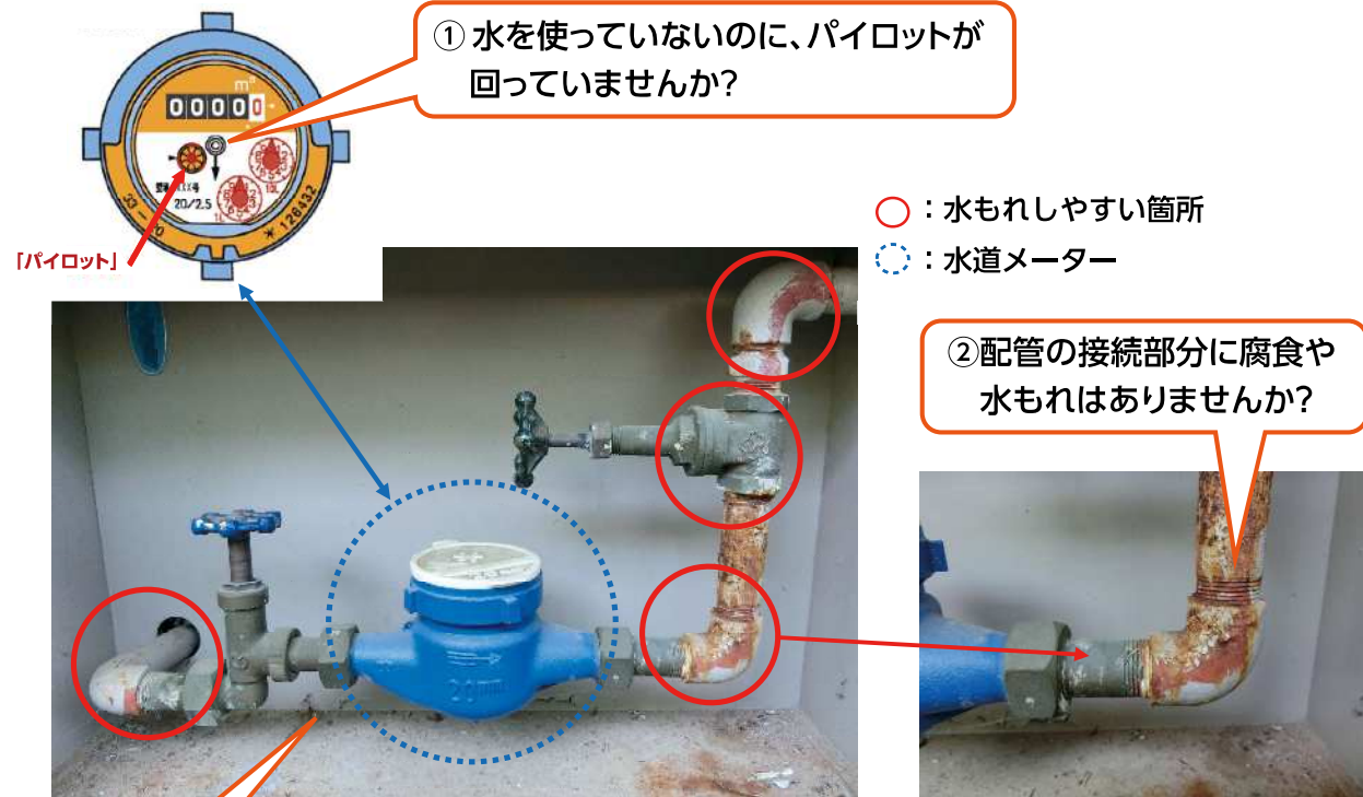
(写真) 水道メーター設置例
