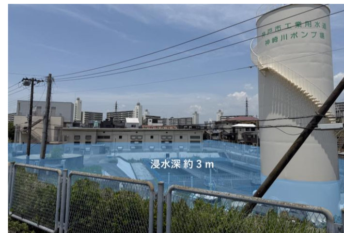
神崎川ポンプ場の想定浸水深（3m）
