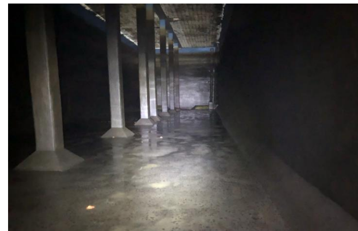
本山調整池の内部
