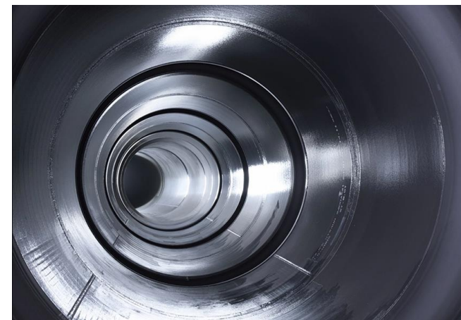
大容量送水管の内部(直径2.4m)
