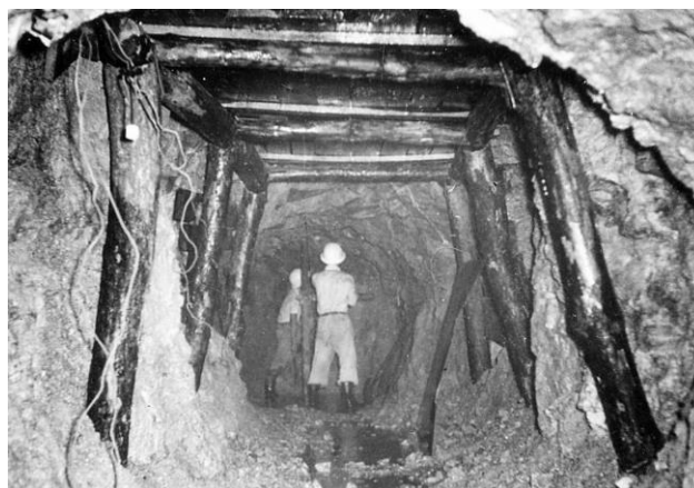
3 拡送水トンネルの掘進状況
