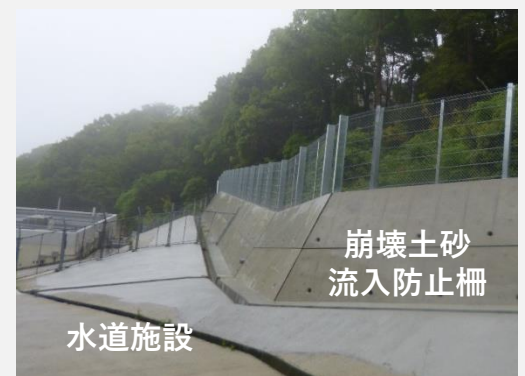
水道施設の土砂災害対策
