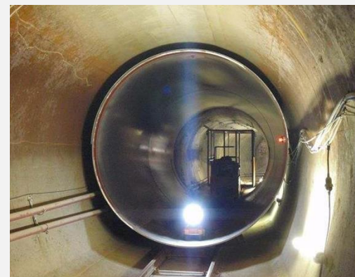
送水幹線の再整備（鋼管挿入）
