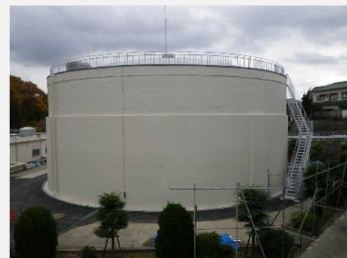
水道施設の耐震補強工事
