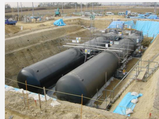
公園地下への大規模貯水槽の設置 （災害時でも一定期間の応急給水が可能）
