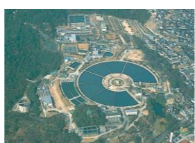
上ヶ原浄水場(西宮市) 浄水能力—7万m 3 /日
