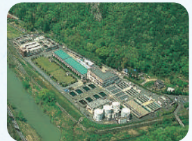
千苅浄水場（北区） （浄水能力:10.8万m 3 /日）
