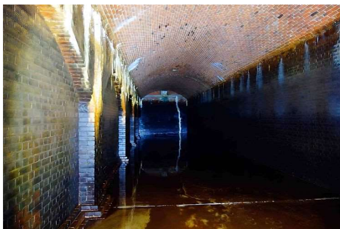
奥平野低層配水池
