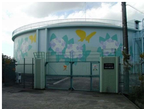
西神低層配水池
