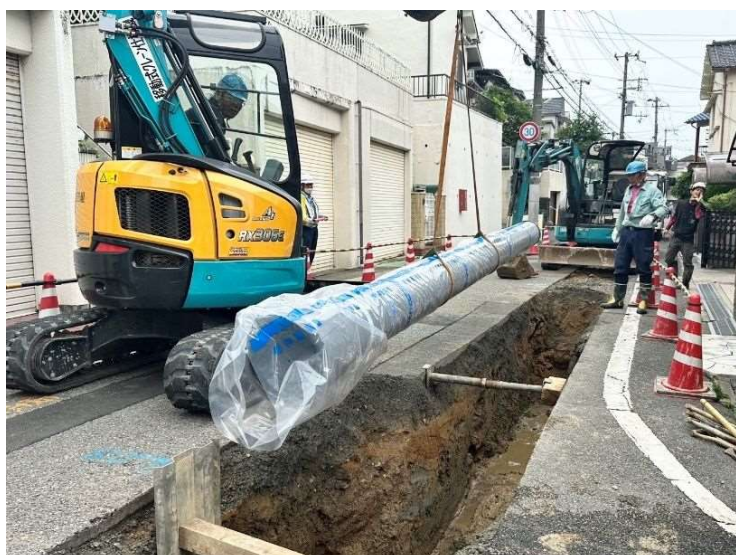
配水管更新工事 (開削)
