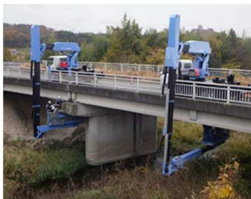
橋梁点検車による点検
