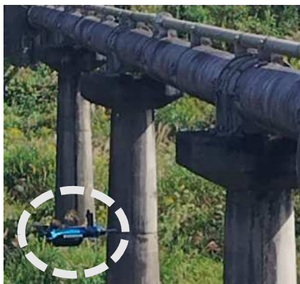
ドローンによる点検
