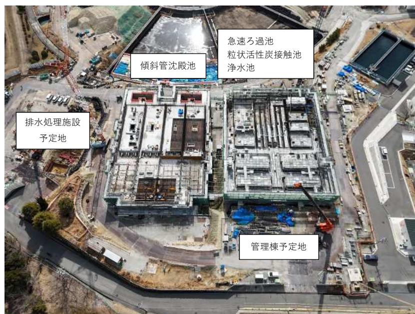
建設状況（令和 7 年 2 月）
