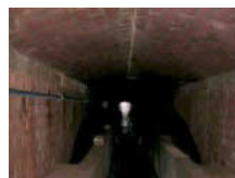
奥平野低層配水池
