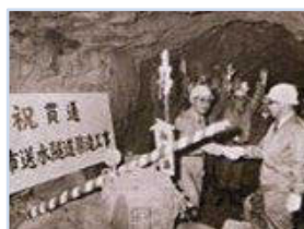
送水トンネル貫通（拡張期）
