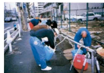
仮設給水栓での 応急給水
