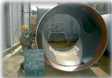
挿入前の鋼管
