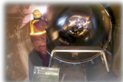
トンネル内の工事の様子
