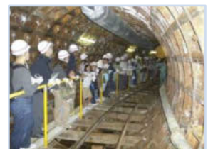
大容量送水管のトンネル内
