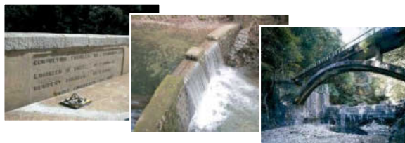
布引水源地水道施設（国の重要文化財）
