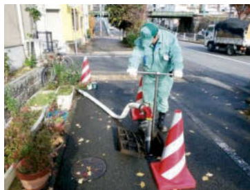
道路にある消火栓から放水
