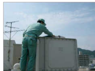
高置水槽の調査
