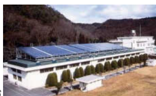
千苅浄水場の太陽光発電
